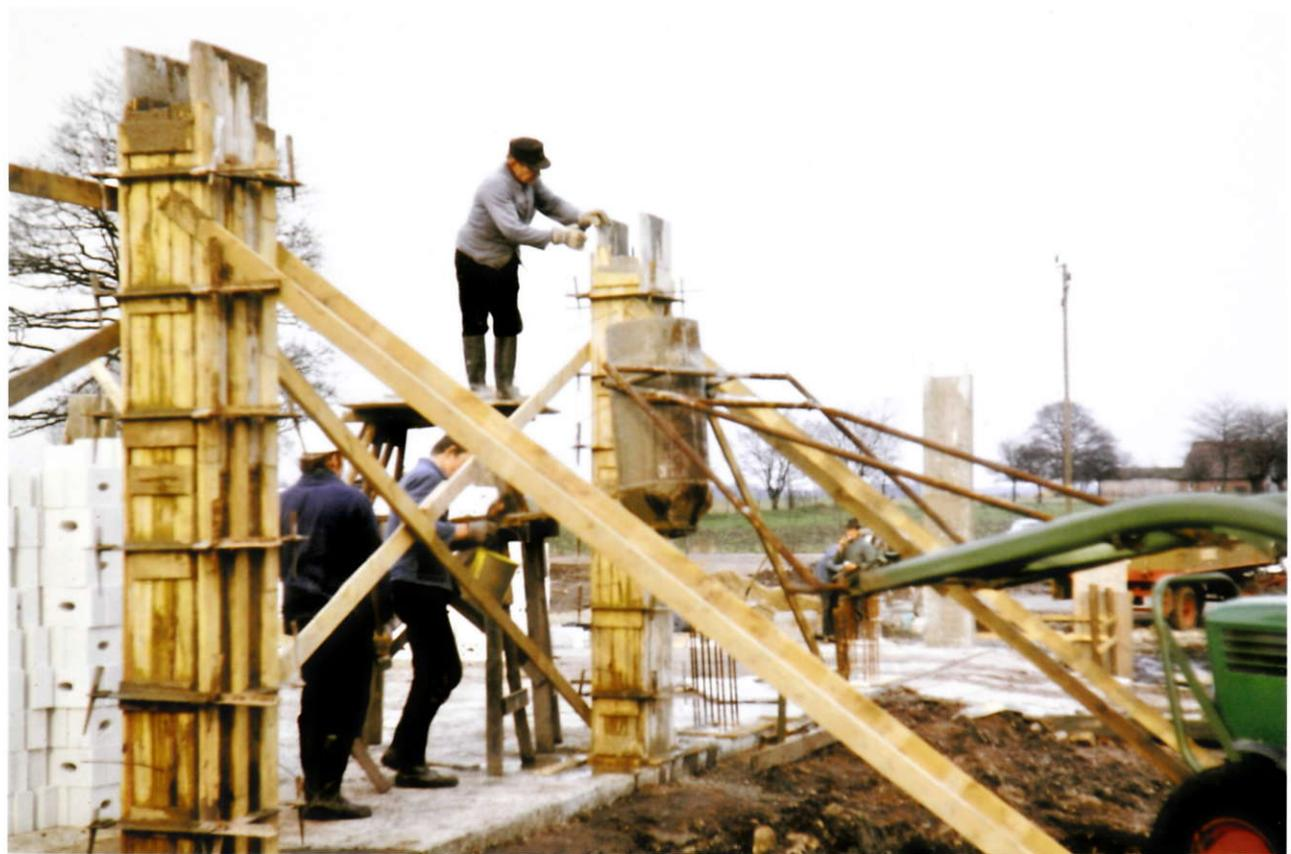
Ernst Heinrichs beim Befüllen der Pfeiler. Die selbst-gebaute Betonbombe von Fritz Krüger im Einsatz.
